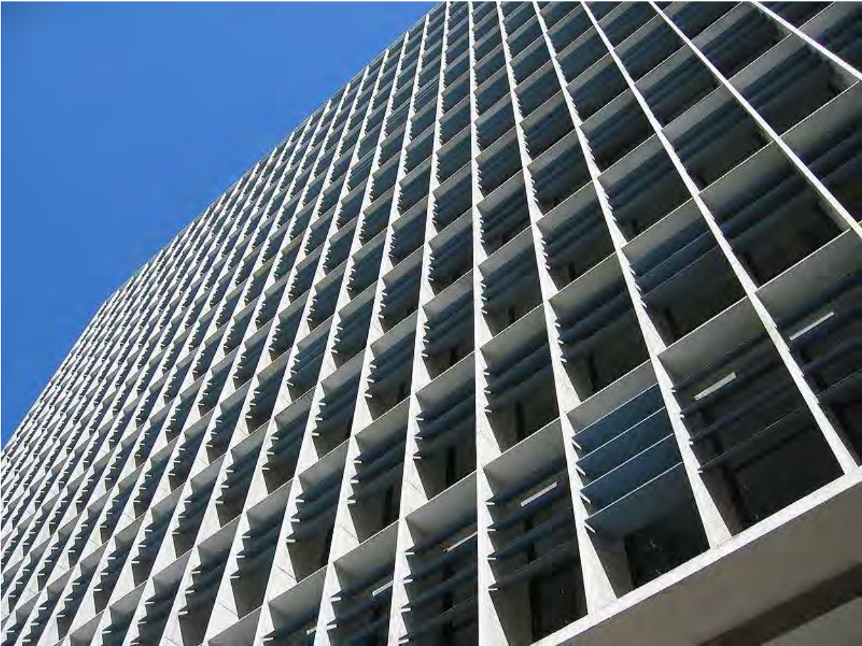
Imagen 4: Fachada con elementos horizontales y verticales de sombreamiento
