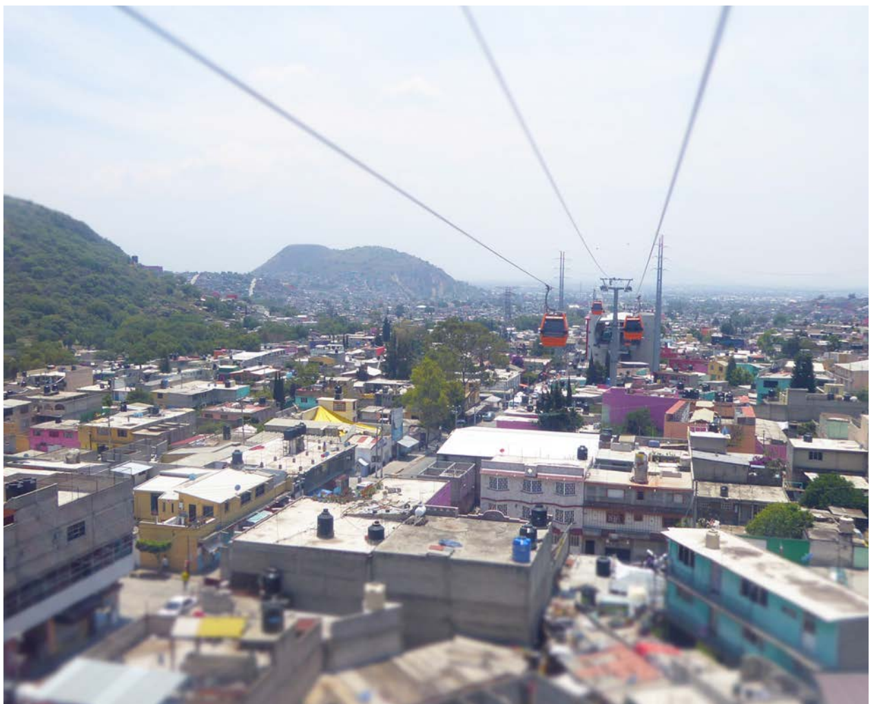
Mexicable Ecatepec. Fotografía: Alejandro Palmerín.
